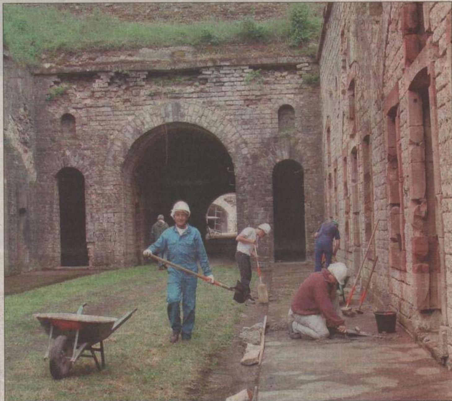
La soixantaine de bénévoles ne s'est pas ennuyée. Entre maçonnerie, nettoyage... les tâches n'ont pas manqué.
