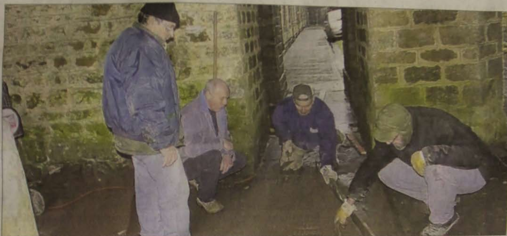
Un couloir a été aménagé pour mener directement à la boulangerie.
