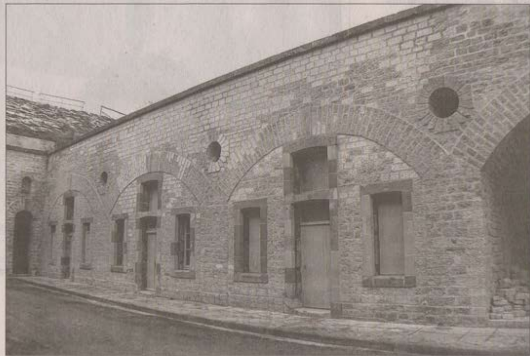
■ La réfection des voûtes de la cour d'honneur ouest a été réalisée de mars à décembre 2014.
