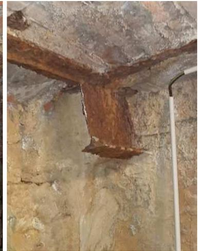
12.12.2018 : Avant cela, il a fallu « nettoyer » les poutrelles métalliques quelque peu rouillées...
