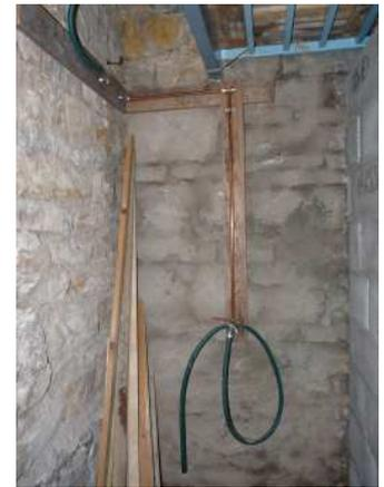
De son côté, George Kuehm a également installé les canalisations permettant de remplir la cuve de 1000 litres se trouvant au dessus des toilettes pour l'alimentation en eau venant des citernes du Fort.
